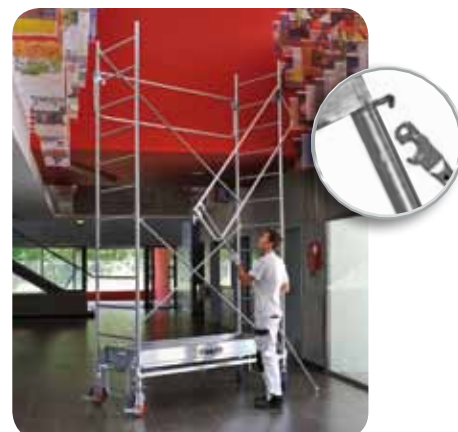
2 On insère le crochet du garde-corps dans l'orifice de la diagonale prévu pour le recevoir.
